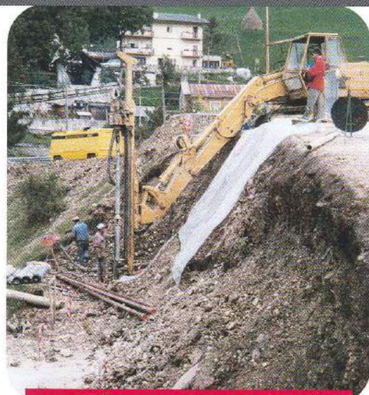
consolidamento scarpata stradale
